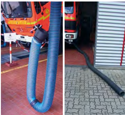
Abgasabsaugung im Werkstattbereich
