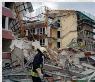
Einsturz eines Gebäudes durch unsachgemäße Bauarbeiten
