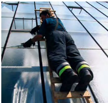
Beschädigte Glasscheiben eines Gewächshauses werden nach Beschädigung durch Hagelschlag vorsichtig entfernt (Feuerwehrhelm und Schutzjacke wurden auf Grund großer Hitze abgelegt).
