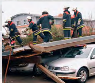
Einsturz durch Überlastung der Carport-Konstruktion
