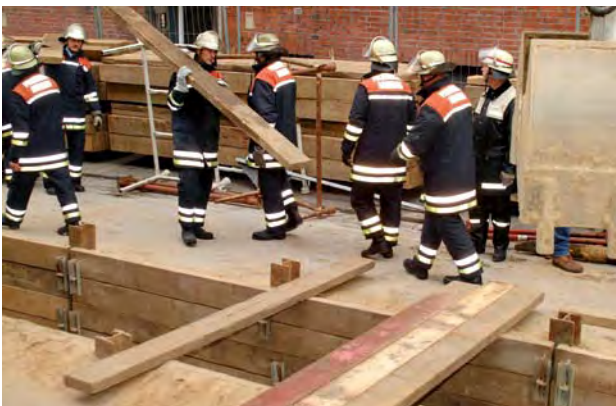
Behelfsmäßiger Übergang aus Bohlen
