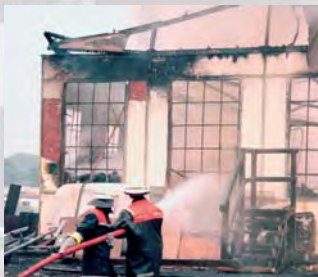
Einsturzgefahr der Fassade durch Brandeinwirkung
