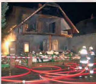
Fassadeneinsturz nach Explosion
