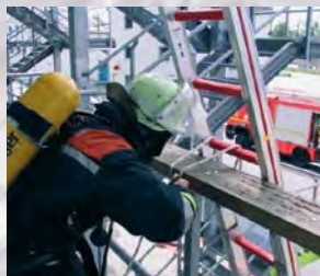
Sicherung des Leiterkopfes gegen Abrutschen
