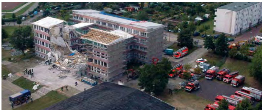
Einsturz eines Schulgebäudes durch unsachgemäße Bauarbeiten
