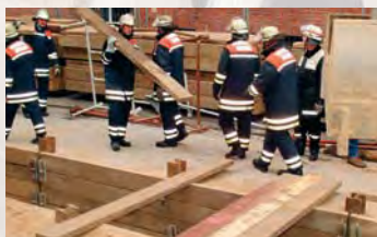
Behelfsmäßig hergestellter Über- gang aus Bohlen
