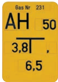
Hinweisschild für Absperrorgan einer Gasverteilungsleitung
