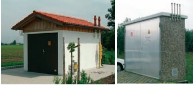
Gas-Druckregel- und Messanlagen
