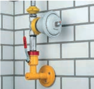
Hauptabsperreinrichtung
